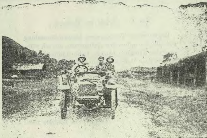
Die Autohalle in Lambi, die kleinen Häuser sind die Wohnungen der Fahrer, in der Mitte der Adlerwagen mit Oskar Meyer und Fritz Grasser.
